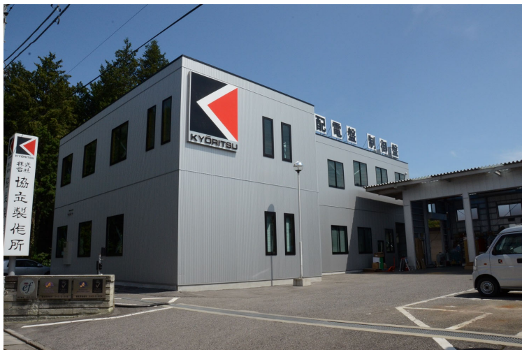
震災後に災害対策を強化して完成した新社屋(2011年10月)
