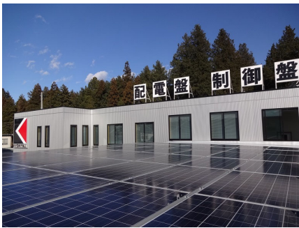
震災後に設置した太陽光発電システム (県内外に23カ所設置)
