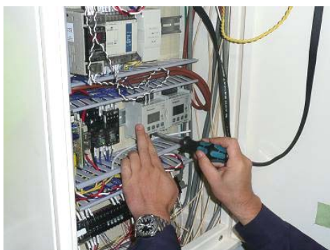
エコパワーメータの設置
