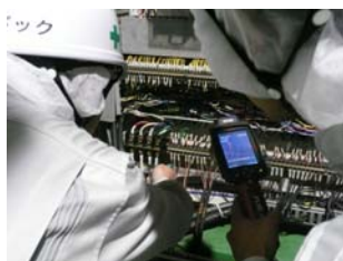
制御盤メーカースタッフによる専門的な検査です
