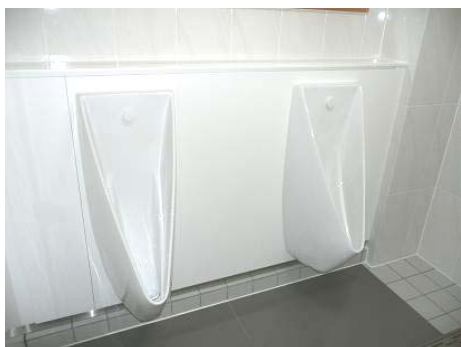
マイクロ波センサー感知し節水効率の高いファジー制御によるの自動吐水
