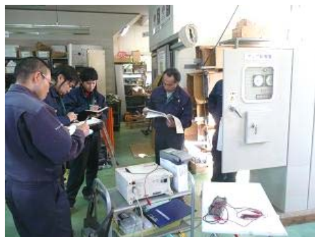
ポンプ制御盤の実物を用いての説明
