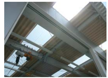
屋根にも採光の設計がしており、昼間は照明が不要です
