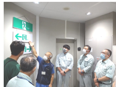
避難口誘導灯・通路誘導灯の説明
