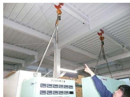
制御盤のスリングによる転倒防止策
