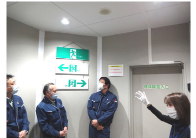
避難口誘導灯・通路誘導灯の説明
